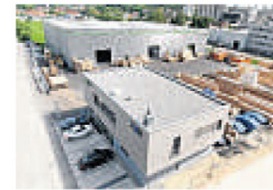
Verpackungs- und Logistikzentrum in Heidenheim-Mergelstetten.
